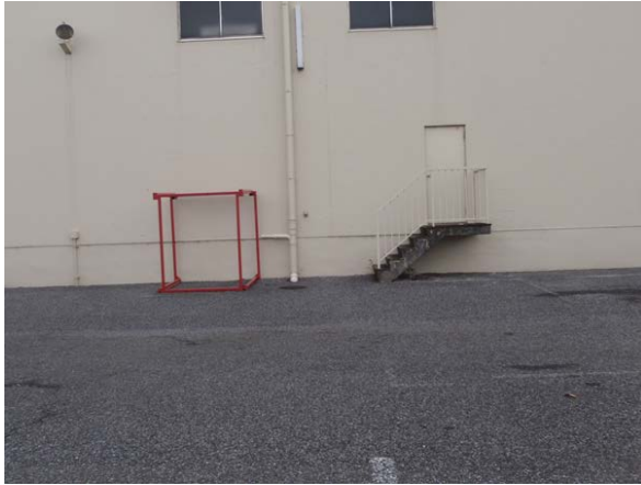
環大No.1 丸沼倉庫
