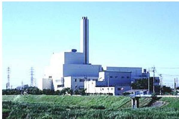
図 2-3 朝霞市クリーンセンターの外観
