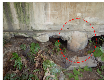
基礎の露出状況
