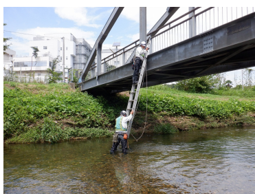
梯子を使用した点検状況
