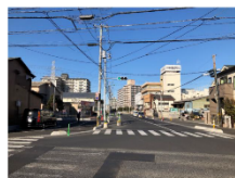
整備後の観音通線
