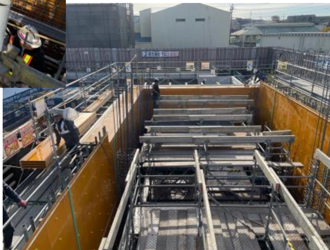
令和6年12月 型枠建込作業
