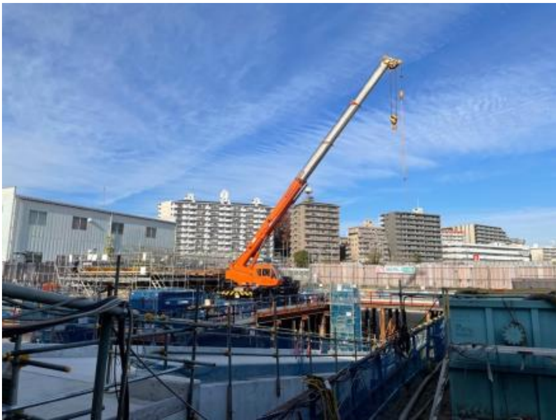
令和6年12月 材料搬入状況
