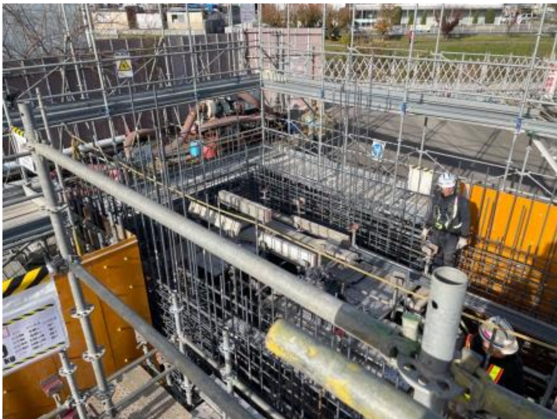
令和6年12月 鉄筋組立作業
