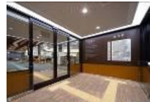
図書館本館改修工事での点字付案内板設置
