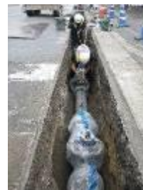
水道管耐震化工事
