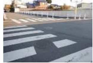
市道20号線 歩道築造工事 (根岸台二丁目交差点 付近)
