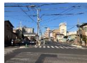
整備後の観音通線
