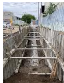
雨水管布設工事
