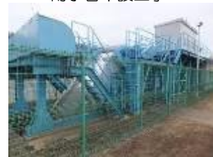
浜崎排水機場
