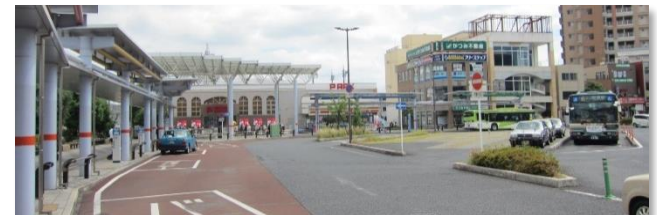
⑧ ロータリーは空間や幅員に余裕があり、車の利便性は良いが、その分人が利用できる歩道や広場は狭い。 ⑨ 志木駅、大泉学園駅、254号線付近、新座方面など、各方面への路線バスが発着し、交通結節点として利用客が多い ⑩ 全体的に憩いとなる緑が少ない
