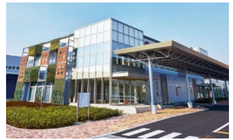
環境配慮型の建物
