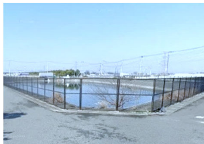
雨水貯留施設の設置
