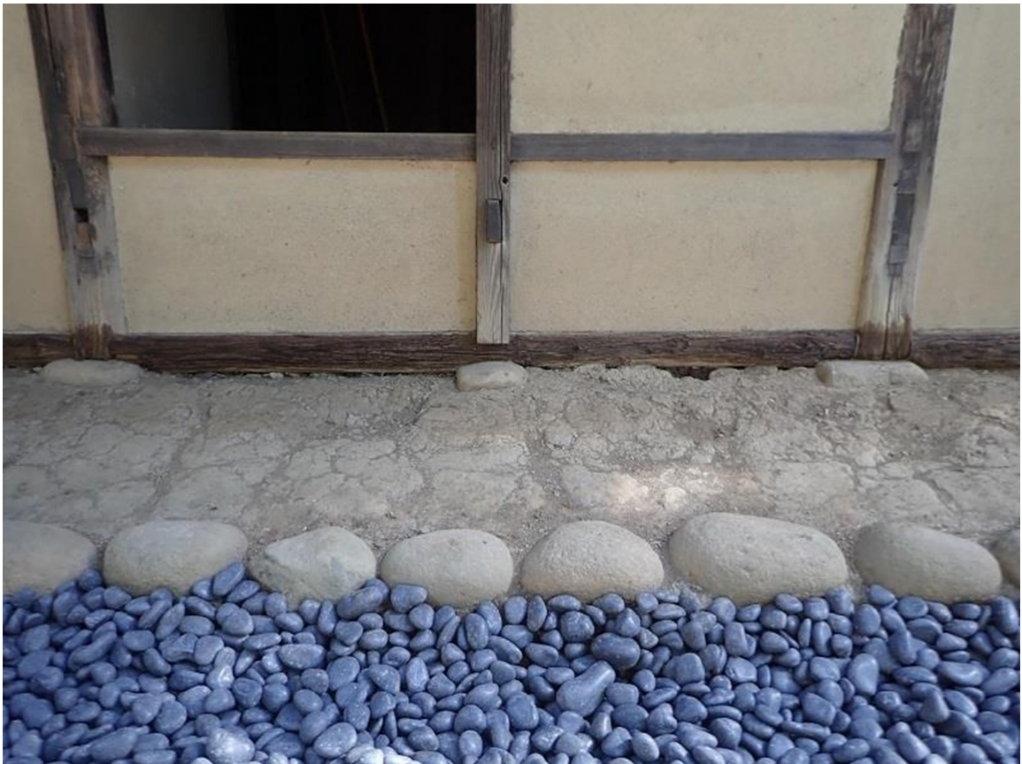
【防腐防蟻剤塗布（土台部分）】
