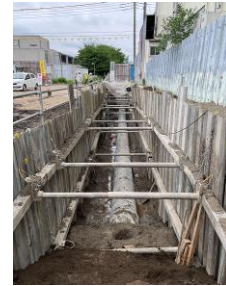
雨水管布設工事
