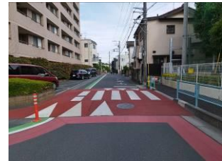
スムーズ横断歩道の設置
