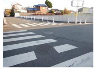
市道20号線 歩道築造工事 (根岸台二丁目交差点 付近)
