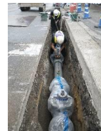
水道管耐震化工事
