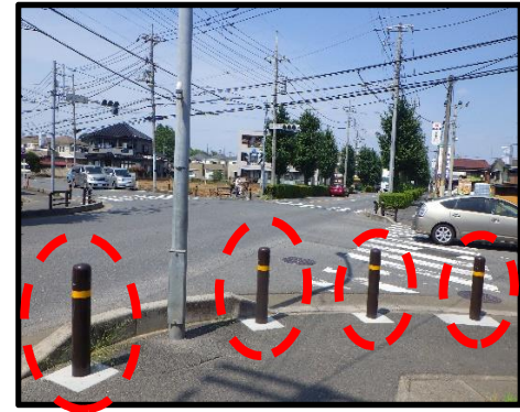
【車止めポール】
