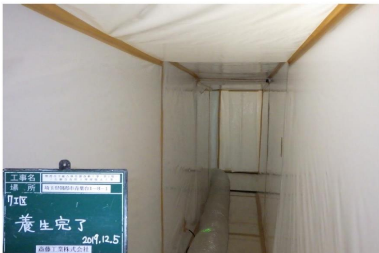
① 養生状況
