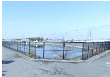
雨水貯留施設の設置
