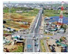
広い幅員の道路（朝霞市内）
