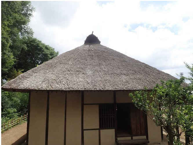
主屋 茅葺屋根 西側 全景
