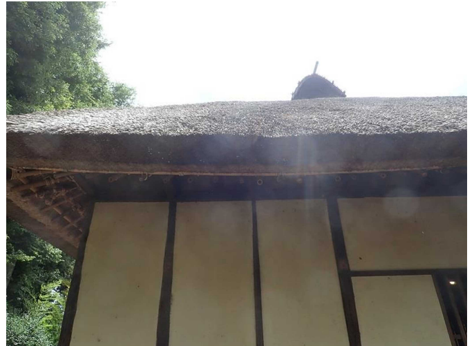
主屋 茅葺屋根 西側 拡大
