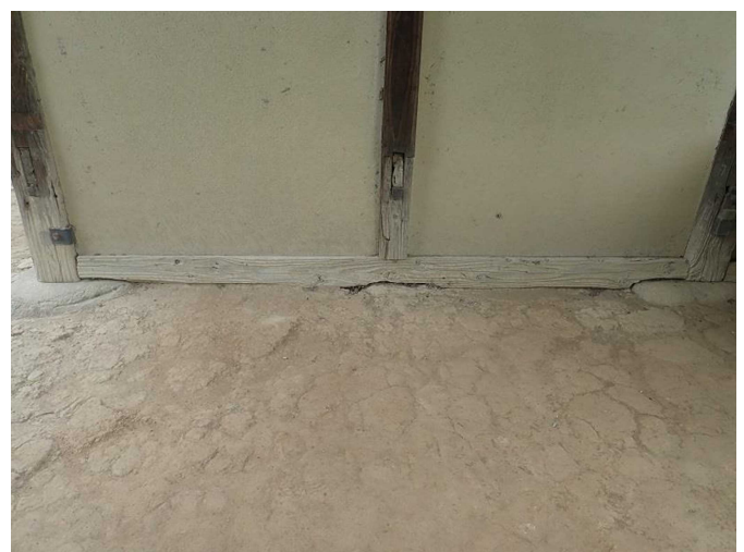
建物土台部分（西側）
