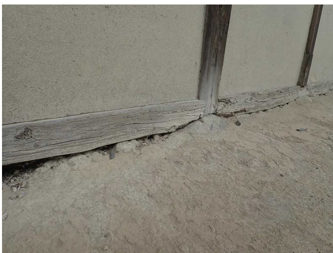
建物土台部分（北側）
