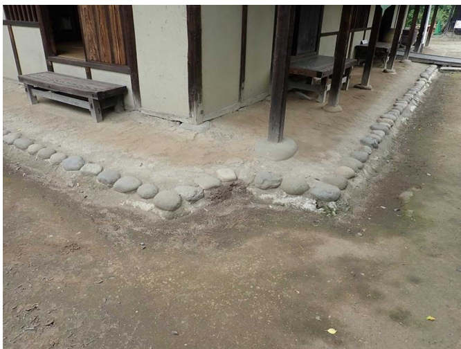
雨落周囲状況（主屋西～南側）
