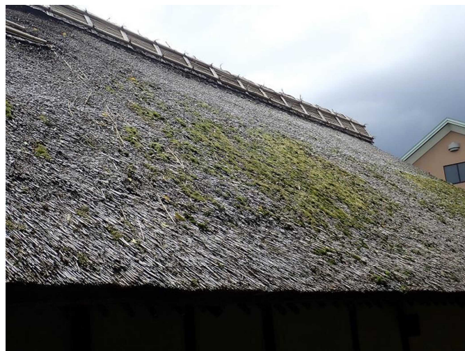
主屋 茅葺屋根 北側
