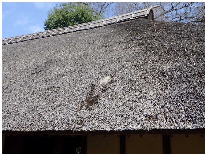
主屋 茅葺屋根 南側
