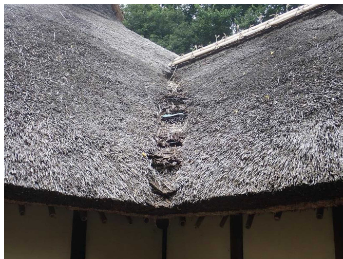
主屋 茅葺屋根 東側・谷部分
