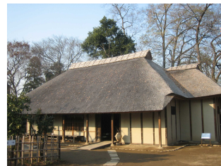
国指定重要文化財 「旧高橋家住宅」
