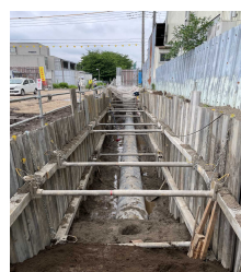
雨水管布設工事
