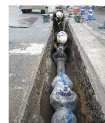
水道管耐震化工事
