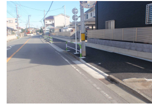
市道15号線 歩道築造工事
