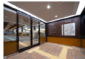
図書館本館改修工事での点字付案内板設置
