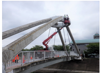
高所作業車を使用した点検状況
