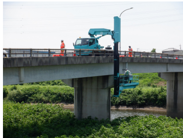
高所作業車を使用した点検状況
