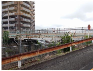
J R 武蔵野線に架かる橋 (浜崎橋)
