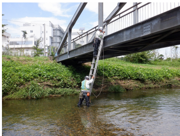
梯子を使用した点検状況
