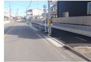
市道15号線 歩道築造工事
