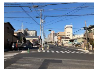
整備後の観音通線
