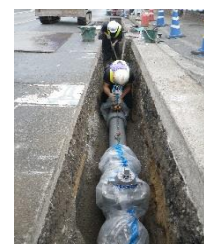
水道管耐震化工事
