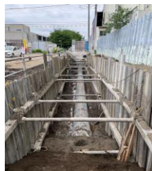
雨水管布設工事
