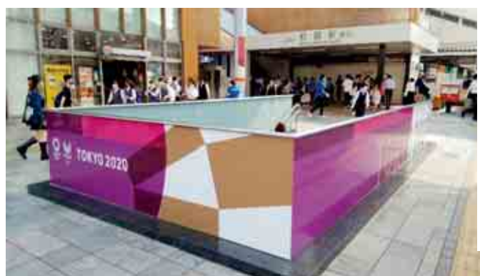
フェンスラッピング(朝霞駅南口)
