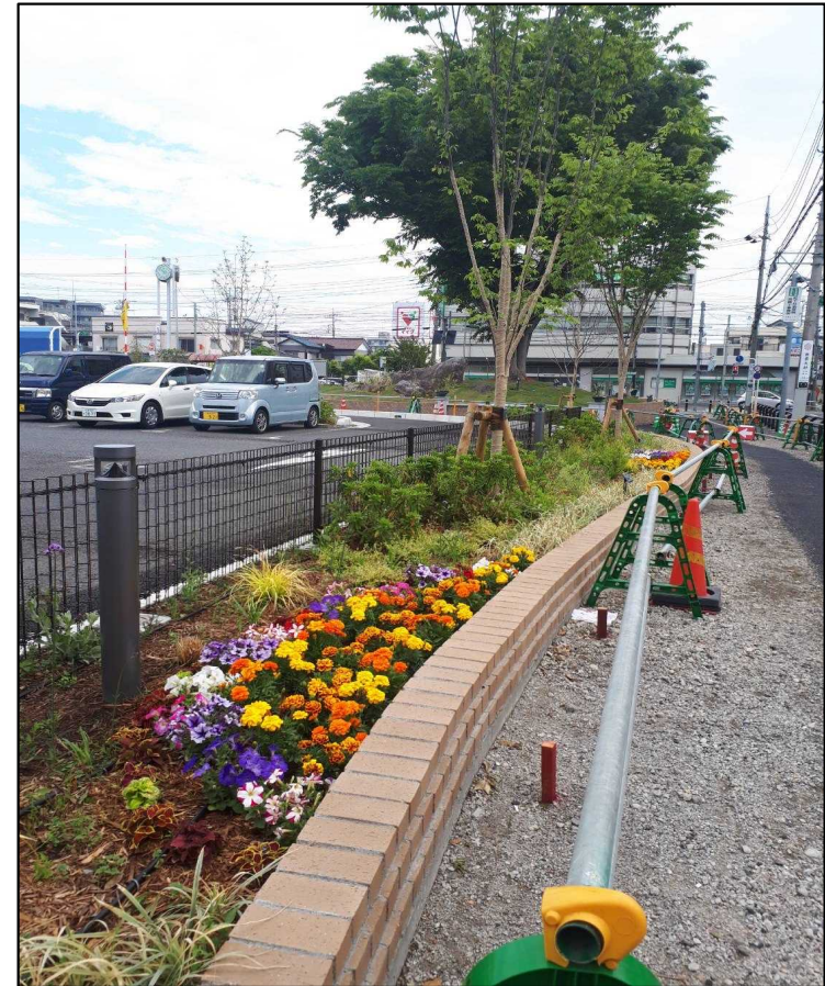
施工例（花壇の設置）
