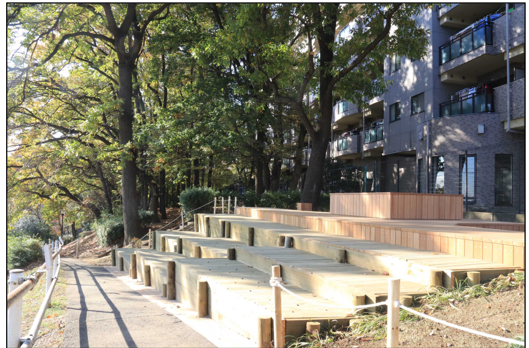
施工例（休憩施設：：ウッドデッキ⇒視点場の設置）
