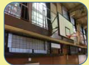
学校の体育館に設置を進めているエアコン
