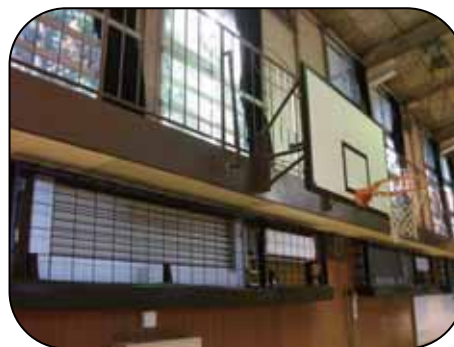
学校の体育館に設置を進めているエアコン
