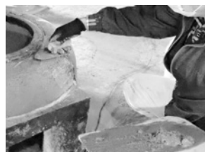
左官技法による修理
