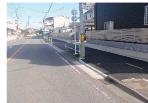
市道15号線 歩道築造工事
