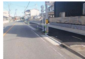
市道15号線 歩道築造工事
