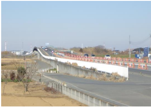
朝霞大橋 全景
