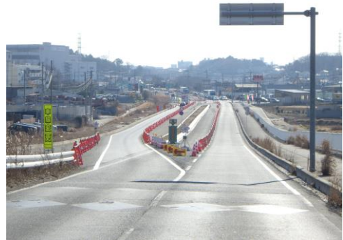
4車線化工事の状況（平成31年1月撮影）
