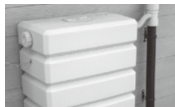
市内の雨水貯留槽設置例
