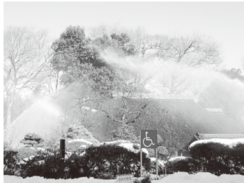
放水銃からの放水
