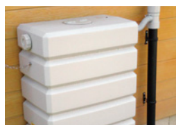
市内の雨水貯留槽設置例
