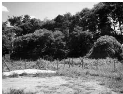
整備工事前の湧水代官水 (平成22年)
