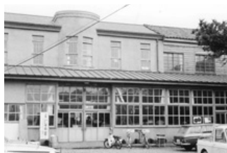
市役所旧庁舎(昭和43年頃)
