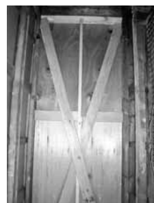
たすき掛けに筋かいを設置した壁（内側を撮影）
