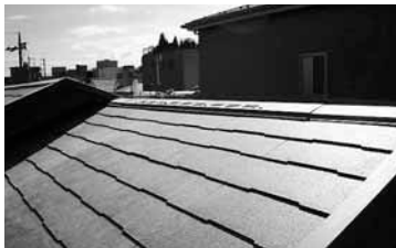
瓦を撤去し、軽量化した屋根
