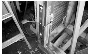
金物で緊結・補強した基礎と土台
