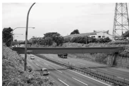
野火止水路橋 (新座市)
