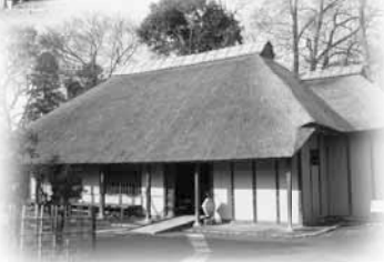
修理後の旧高橋家住宅▶
