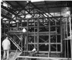
修理中の様子
