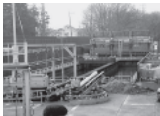
小平監視所(立川市・小平市) 小平市側から撮影しました。ここが、玉川上水の現役水路としての終点です。
