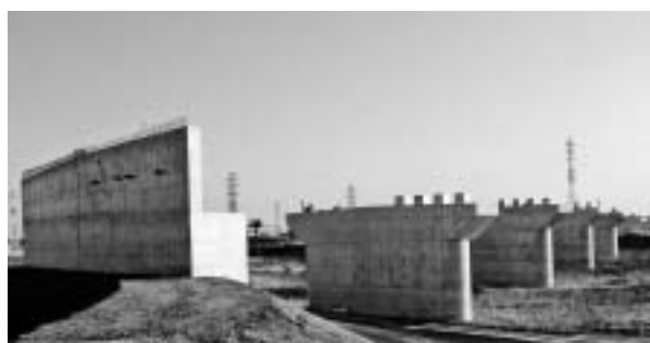
(仮称)「朝霞大橋」下部工完成
