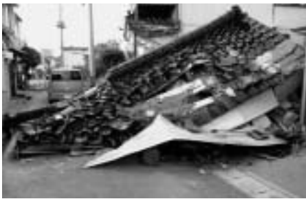
地震のたびに古い木造家屋の危険性が指摘されています。
