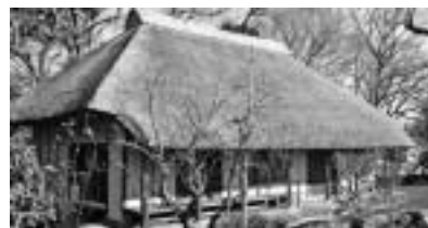
保存修理が完了した旧高橋家住宅主屋
