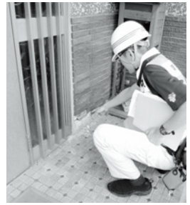
応急危険度判定の様子
