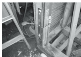
金物で緊結・補強した基礎と土台
