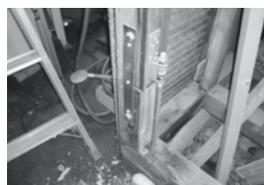
金物で緊結・補強した基礎と土台
