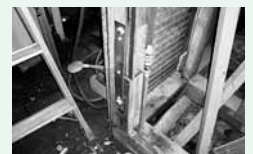
金物で緊結・補強した基礎と土台
