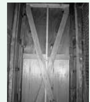
たすき掛けに筋かいを設置した壁(内側を撮影)
