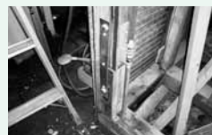
金物で緊結・補強した基礎と土台
