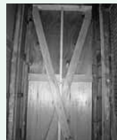
たすき掛けに筋かいを設置した壁(内側を撮影)
