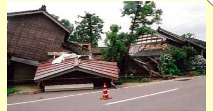
木造建物被害の例(平成19年新潟県中越沖地震)
