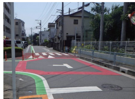
図 スムーズ横断歩道の設置事例 （朝霞市東弁財地区）
