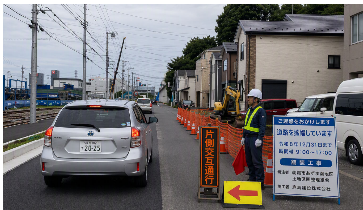
図5 【区間①】住宅側施工時の片側交互通行規制 (生成AIによりイメージを作成)
