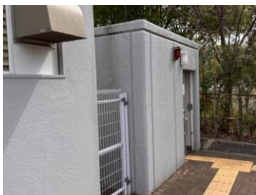
■多目的トイレ
