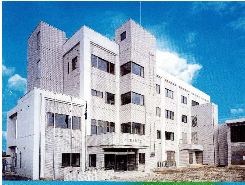
泉水浄水場・水道庁舎
