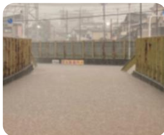
ゲリラ豪雨による浸水被害 (本町 1 丁目/令和 6 年 7 月)
